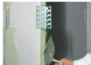
Auch die Murexin Verbindungs-klammer ist rasch montiert.
