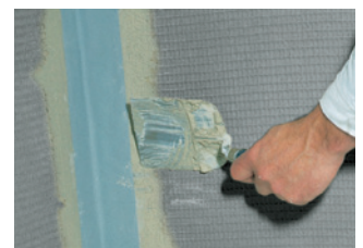
Zuletzt Dichtband einlegen, einfach mit Wandglätter verspachteln – fertig ist der glatte Untergrund!
