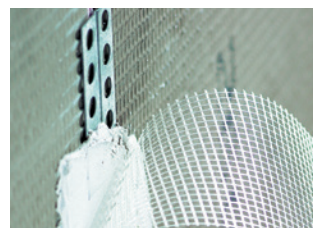
Mit Glasfaser-Gewebestreifen schließen sich Plattenstöße.
